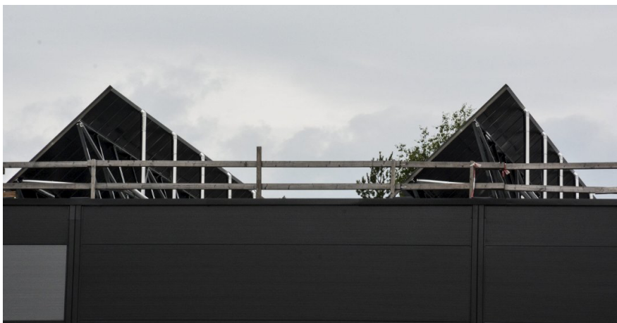
Solfangere: Det største solfangeranlegget som er installert på et enkelt bygg er på toppen av Moelvhallen, skrev Fremtidensbygg.no
